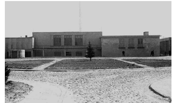
△ Budynek stacji nadawczej Radiostacji w Raszynie, 1946 rok
