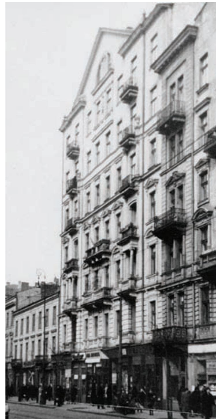
Na zdjęciu z lat 30. widać, że kamienica była zwieńczona trójkątnym szczytem i wyższa o jedną kondygnację. Elewację zdobiła znacznie większa liczba balkonów. APW/Referat Gabarytów
